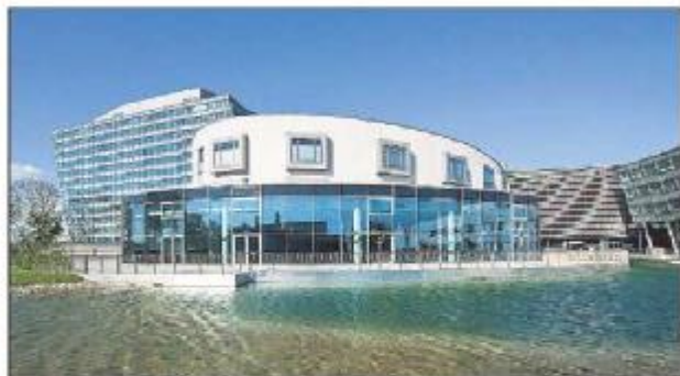
Nachhaltigkeit bedeutet Blick aufs Ganze. Dass auf dem Areal der Siemens City große Flächen nicht zubetoniert sind, entlastet auch die Kanalisation. [Stimme/Österreich]
